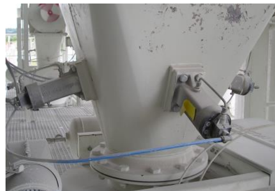
Flere PKL 740 med selvstyring (ST-Kit) monteret på cementbeholder
